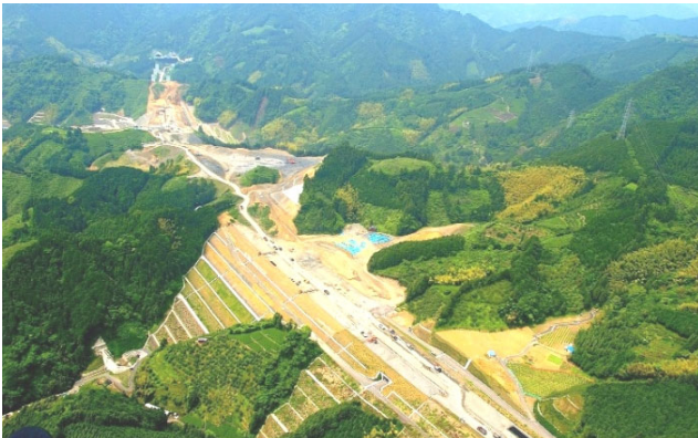
(b) ゾーニング施工された高さ 90 m の高盛土 写真-8 脆弱岩破砕土を用いた盛土
