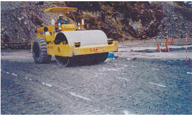
(a) 脆弱岩破砕土の転圧状況
