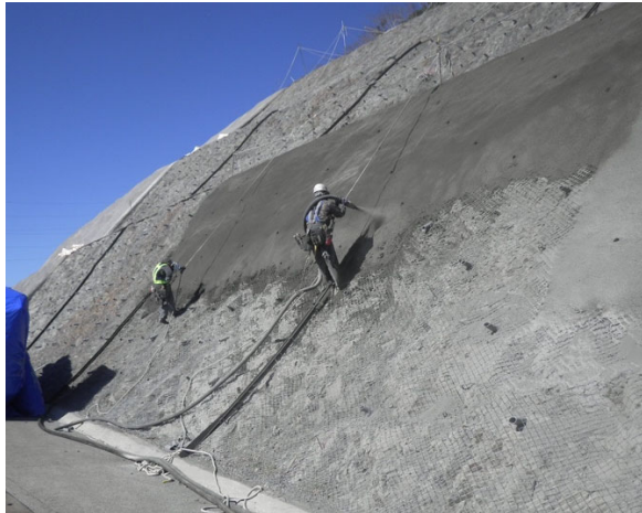
(a) モルタル吹付けの様子
