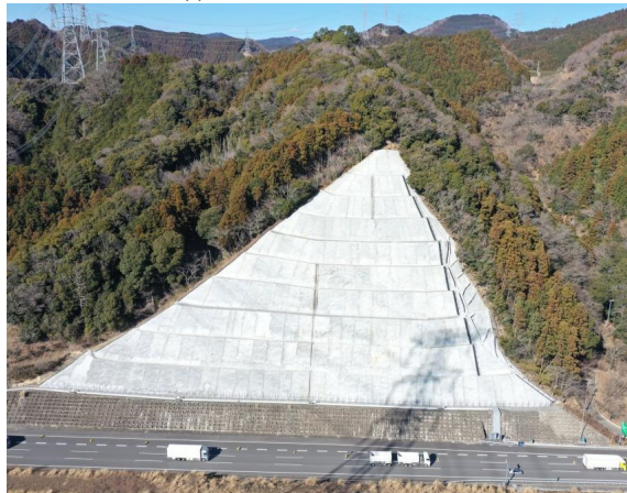
(b) モルタル吹付け工を施した切土斜面 写真-7 モルタル吹付け工
