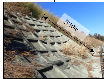
写真-6 表層崩壊箇所の復旧状況(コンクリート杭工)
